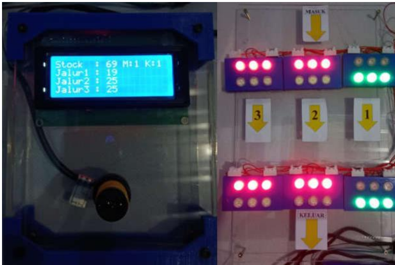
Gambar 4.3 Kondisi lampu dan box monitor LCD pukul 9.30
